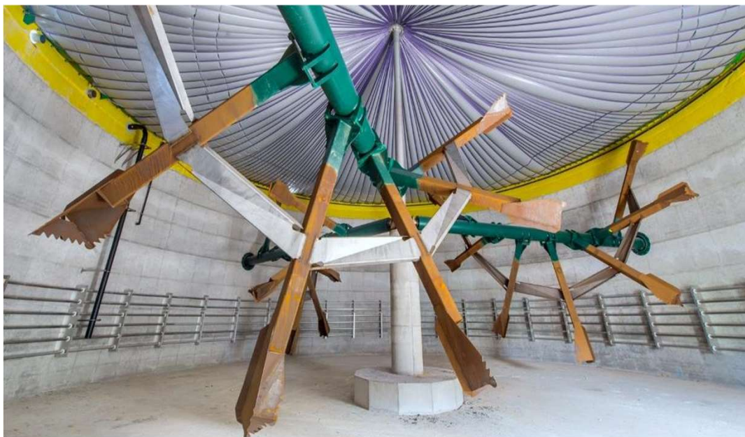
Fot. 2. System mieszania wewnątrz reaktora fermentacji
