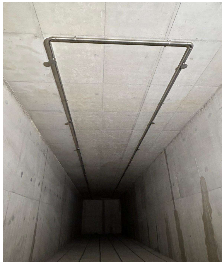
Fot. 10. Fermentacja okresowa sucha – wnętrze reaktora
