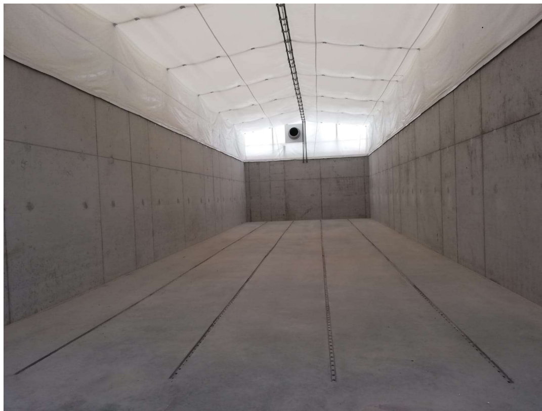
Fot. 12. System napowietrzania po zalaniu posadzki
