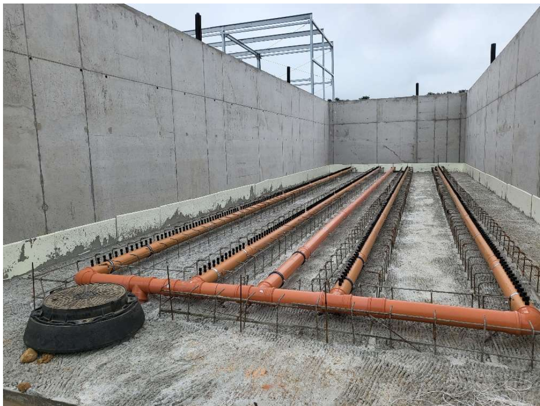
Fot. 11. System napowietrzania przed zalaniem posadzki
