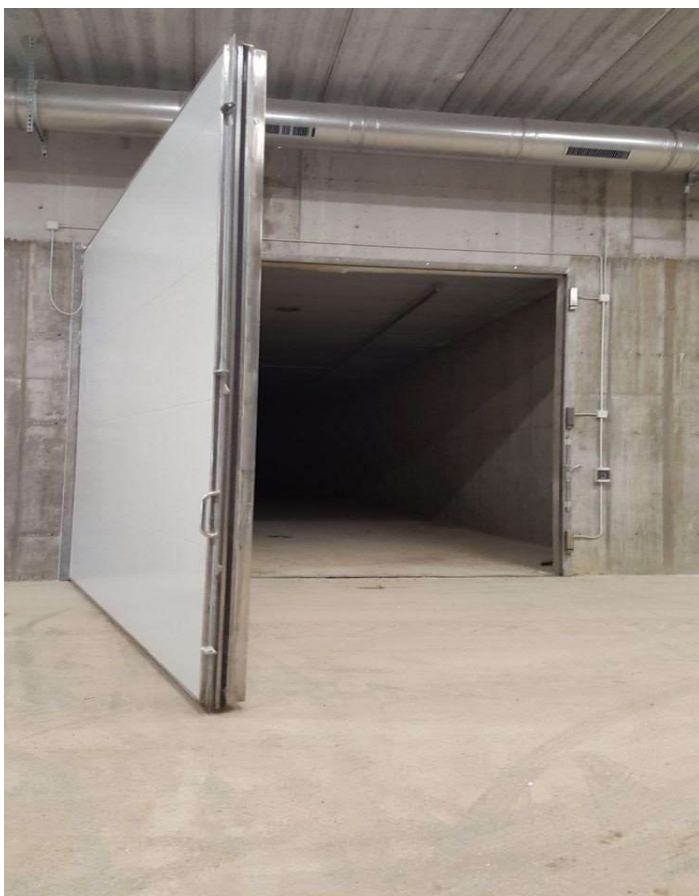
Fot. 9. Fermentacja okresowa sucha – brama reaktora
